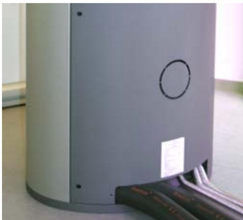
**Bild 5** ■ Verbrennungsluftanschluss - zum Ausbrechen ■ Typenschild ■ Anschlusslösung nach hinten
